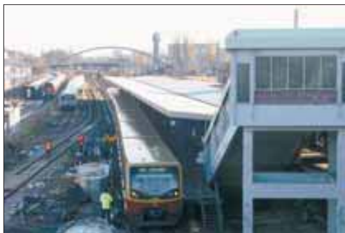
S-Bahnhof Warschauer Straße: Am Bahnsteig C hält eine S-Bahn Richtung Innenstadt. Von der Warschauer Brücke aus gesehen links sind die Fundamente für die provisorische Brücke vorbereitet. Ist sie fertig, wird im neuen Jahr das alte Empfangsgebäude abgerissen (r.). ▶ Fotos: Michael-Peter Jachmann
