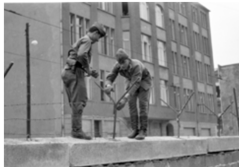
Grenzsoldaten befestigen Abweiser auf der Betonverbundmauer an der Zimmerstraße, 1961
