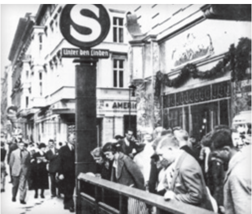
Für den Boulevard Unter den Linden gestaltete der Reichsbahn-Architekt Richard Brademann die Treppenzugänge des gleichnamigen Bahnhofs (heute Brandenburger Tor) in schlichter Schönheit. Um die Brüstung eines Zugangs drängt sich neugieriges Publikum.
