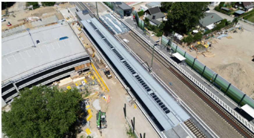
Kombibahnsteig im Sommer 2025
