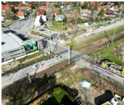
Bf Blankenfelde vor dem Umbau
