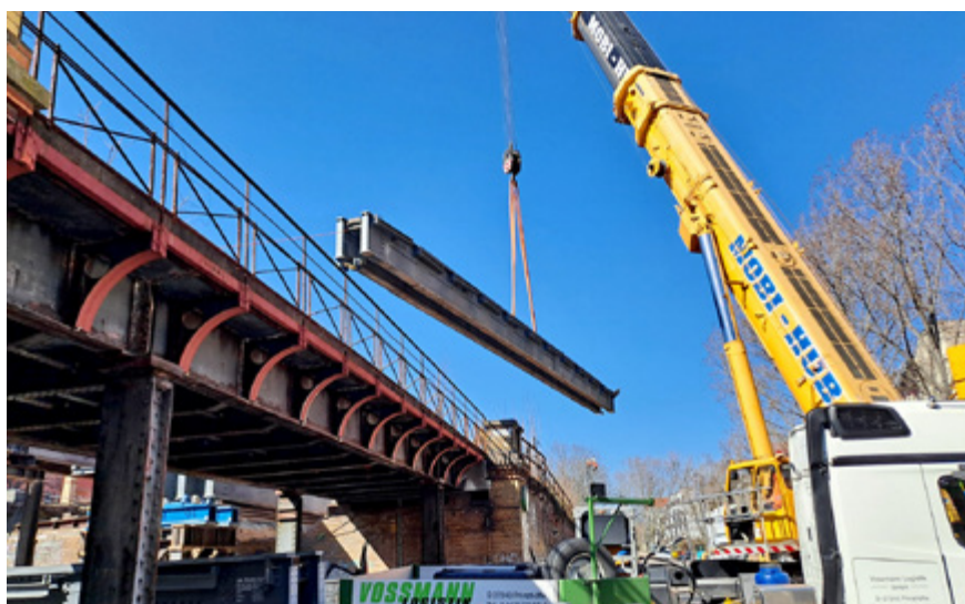
Am 20. März wurden alle Teile für die Hilfsbrücke erfolgreich eingehoben.
