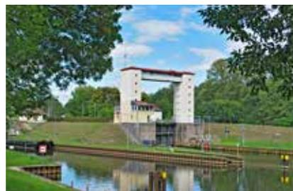
Seit 1940 verbindet die Lehnitzschleuse die unterschiedlichen Wasserspiegelhöhen der Havel-Oder-Wasserstraße miteinander. Täglich werden hier Güterschiffe und Sportboote geschleust, die dabei eine Höhe von sechs Metern überwinden müssen.
