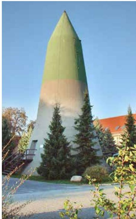
Ein Luftschutzturm der Bauart „Winkel“, auch „Betonzigarre“ genannt.
