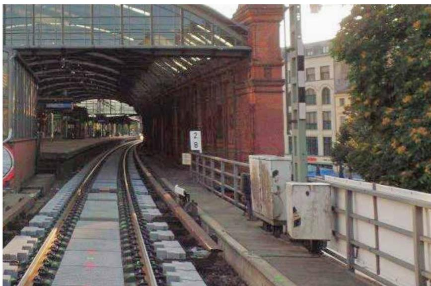
Am Hackeschen Markt sind im Gleis sehr gut die Lärmschutzplatten zu erkennen, die für den Einbau des Zugbeeinflussungssystems zeitweise herausgenommen werden müssen.
