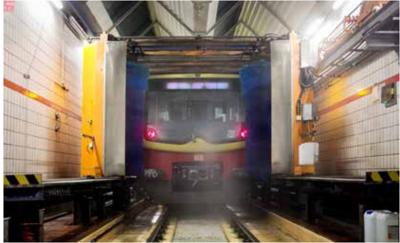
Die Waschanlage für S-Bahn-Züge
