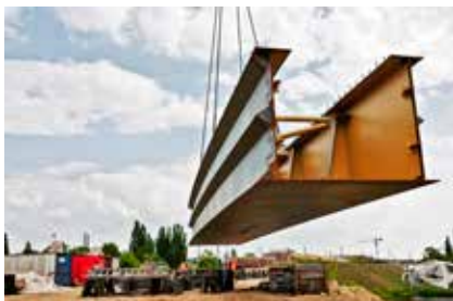
344 Tonnen schwer ist der gesamte Brückenzug, allein ein Teil wiegt mehr als ein S-Bahntriebwagen.
