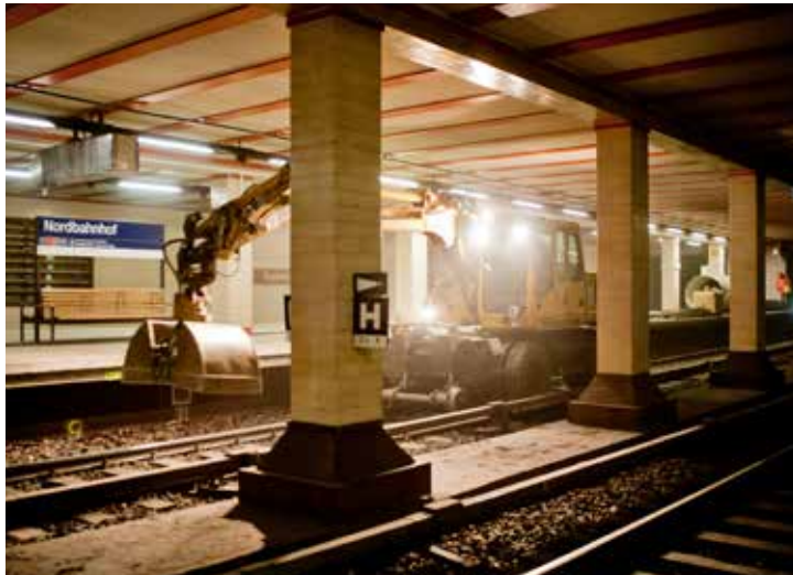
Gespensische Atmosphäre im Nordbahnhof. Wo sonst pro Woche 4 800 Züge fahren, ist jetzt eine Baustelle.
