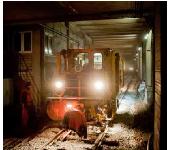
Damit die Schienen richtig auf den Schwellen liegen, bereitet eine Stoppmaschine ihnen das „Bett“.
