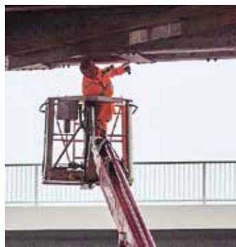
Facharbeiter prüfen vom Arbeitskorb des Schwimmkrans aus den Sitz jeder einzelnen Niete.
