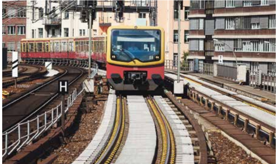
Rechts sind die beiden neuen S-Bahngleise auf der Stadtbahn gut zu erkennen; daneben fahren die Regionalzüge
