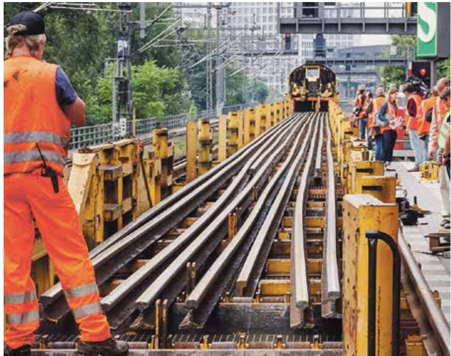
Die „Spinne“ der Maschine mit dem sperrigen Namen Langschienentransporteinheit.
