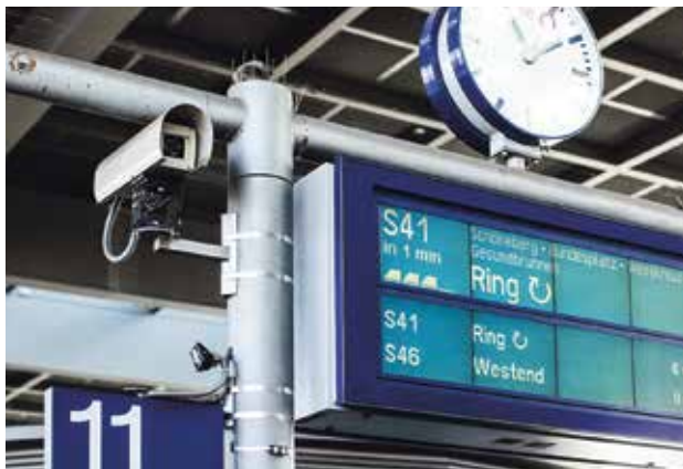
An jeder Bahnsteigseite befinden sich vier von insgesamt rund 700 Kameras, deren Bilder den Vorschriften entsprechend 48 Stunden gespeichert werden.
