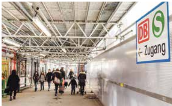
Der Zugang zu den Bahnsteigen 1/2 vom Gesundbrunnen Center aus
