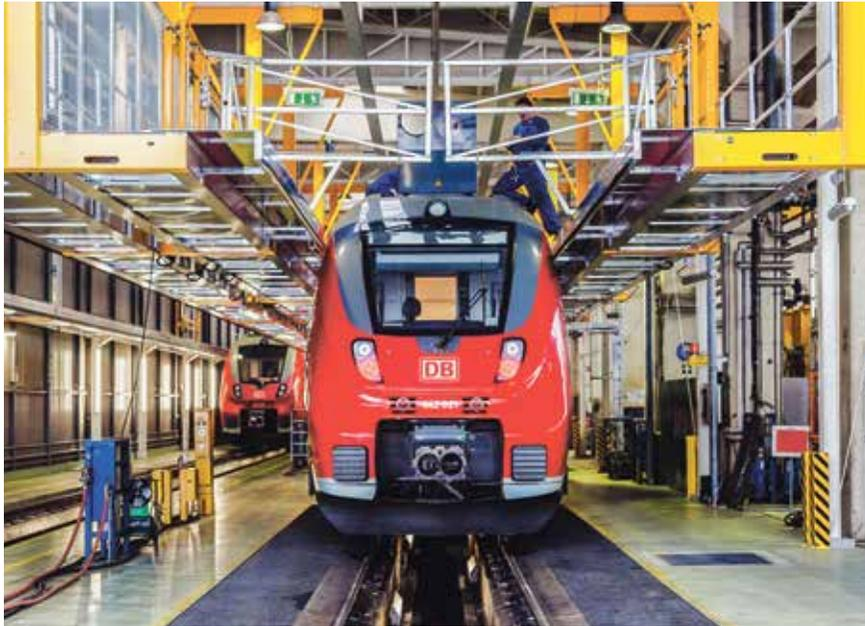
Die neue Dacharbeitsbühne macht den Zugang zu vielen Bauteilen einfacher.
