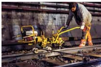
Eine Maschine übernimmt das Schrauben. Im Anschluss liest ein Magnet die alten Kleiseisen auf.
