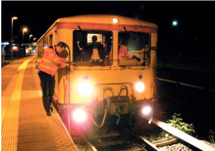
Drei Mann, eine Maschine und der Müll im Bahnsteiggleis
