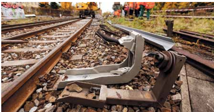
Aus alt wird neu – auf dem Abschnitt wurden Gleise und Stromschienen erneuert.
