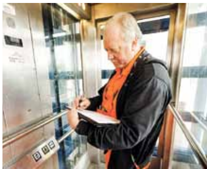
Zu den Aufgaben des Teams gehört es auch, Fahrtreppen und Aufzüge zu kontrollieren. Bernd Fellenberg nutzt dafür eine Checkliste.
