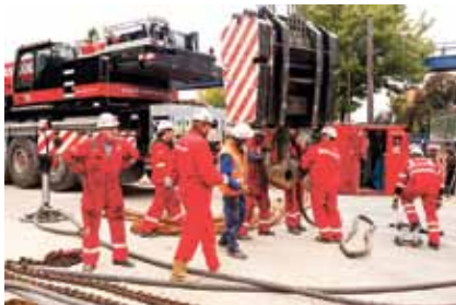
Vorbereitungen für den Hubvorgang: Die Bauarbeiter bringen Mensch und Maschinen in Position, damit die tonnenschweren Brücken an ihre Bestimmungsorte „schweben“ können.
