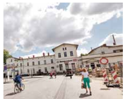
Auch der Bahnhofsvorplatz wird erneuert.
