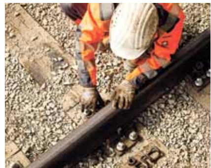
Ein neues Gleis mit Holzschwellenoberbau
