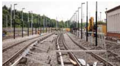
Aus alt wird neu: Kontaminierte Holzschwellen weichen an der Ostseite einer modernen Innenreinigungsanlage.
