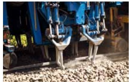
Die Stopfmaschine bei der Arbeit
