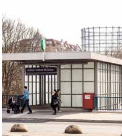
Barrierefreier Zugang zur Station. Im Hintergrund der Schöneberger Gasometer.
