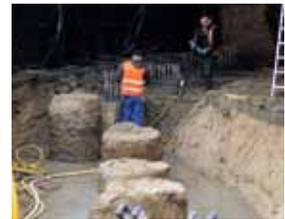
Bohrpfähle ragen bis 15 Meter in die Erde hinein.
