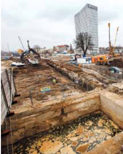
Die Baustelle Anfang Februar
