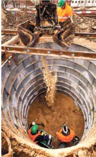
An Verdachtspunkten wird der Boden geöffnet. Die wenigsten sind tatsächliche Gefahrenpunkte, oft finden sich im Erdreich Relikte älterer Gleisanlagen.
