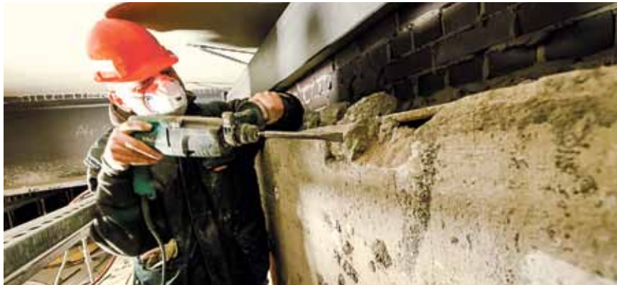
Auf engem Raum und in sechs bis sieben Metern Höhe wird jedes Auflager untersucht und gegebenenfalls per Entlastungsschnitt saniert.
