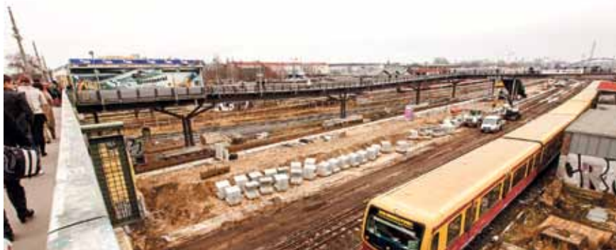
Ist-Zustand: Das Entree zur Station bilden Imbissbuden, die lange Behelfsbrücke führt zum letzten verbliebenen Bahnsteig. Der neue ist im Bau.
