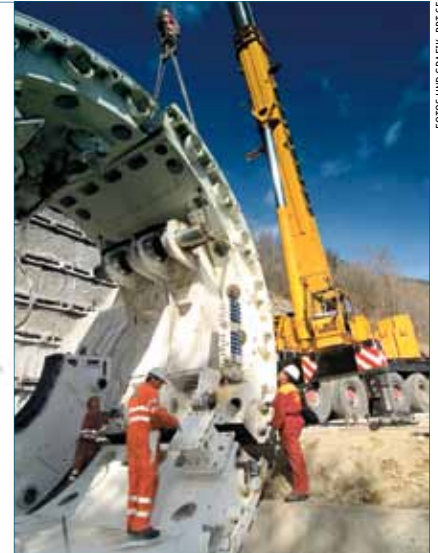
Montage einer Tunnelbohrmaschine
