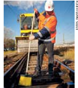
Wenn vom Fahrzeug herabfallende Eisklumpen eine Weiche blockieren, muss sie von Hand mit Hacke und Besen gereinigt werden. Hier vorgeführt von Heino Ressel, Bezirksleiter Betrieb DB Netz.
