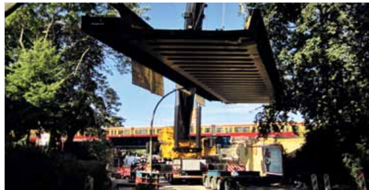
Während die S-Bahn-Züge der Linie S 7 ungestört vorbeifahren, wurde der Überbau eingehoben.
