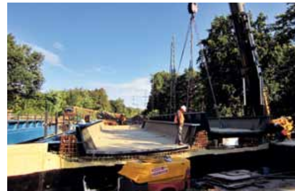
Über diesen Teil der Brücke fahren künftig Regional- und Fernbahnen.
