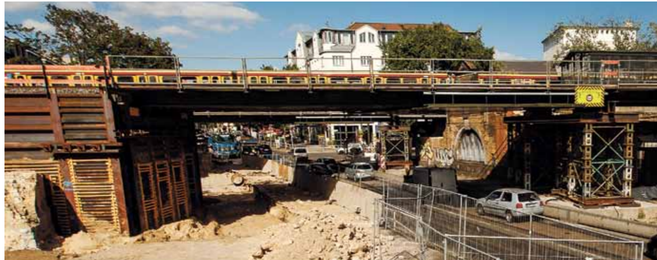
Eingleisige Strecke für die S 3 an der Baustelle der Brücke über die Treskowallee
