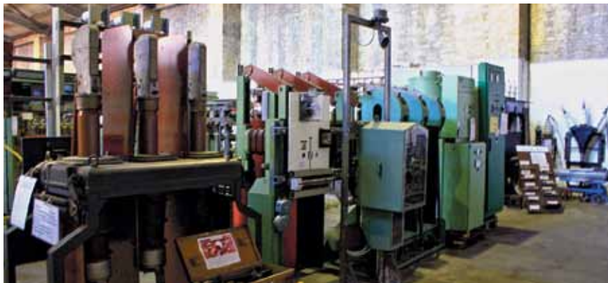
FOTO: BSW GRUPPE BAHNSTROMANLAGEN
