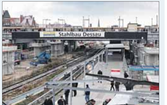
...und dann kann die S-Bahn wieder drunter durchfahren – bis am nächsten Wochenende weitergebaut wird.
