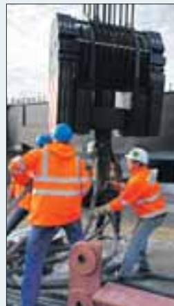
Ein Brückenteil kommt an den Haken,...
