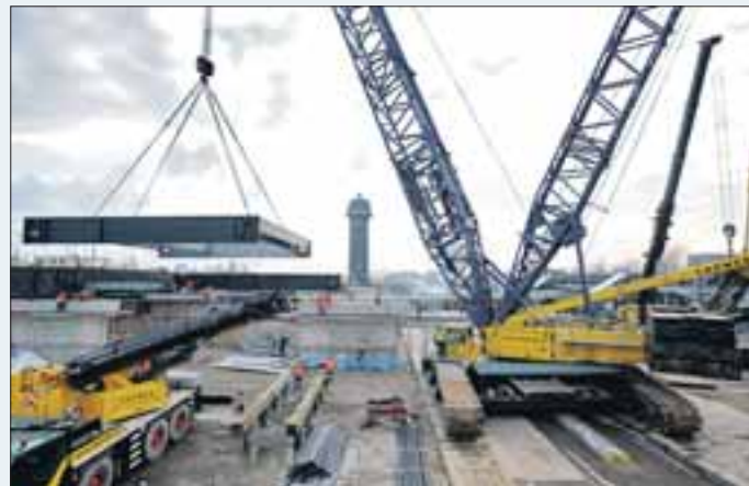
...schwebt über die Gleise zu den Auflagestützen, wird eingepasst...
