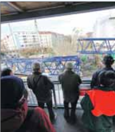
An dieser Baustelle stehen Sie in der ersten Reihe.
