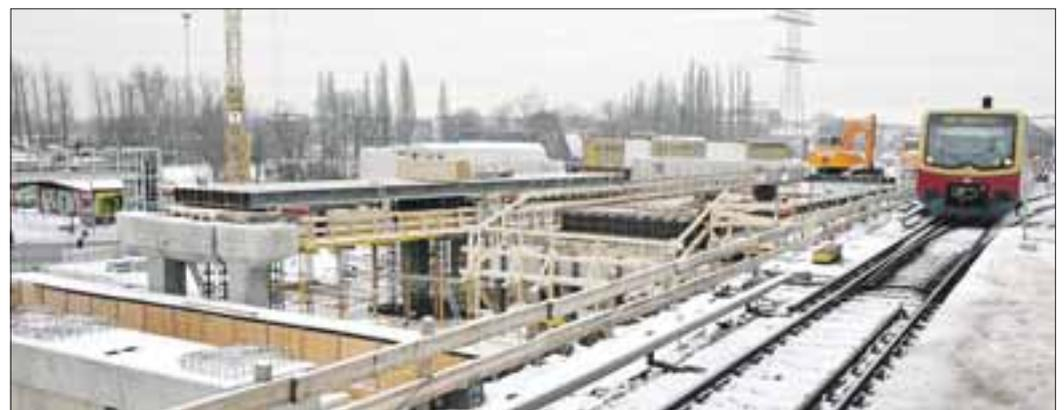
Die Träger für die Ringbahnbrücke über die Hauptstraße wurden montiert
