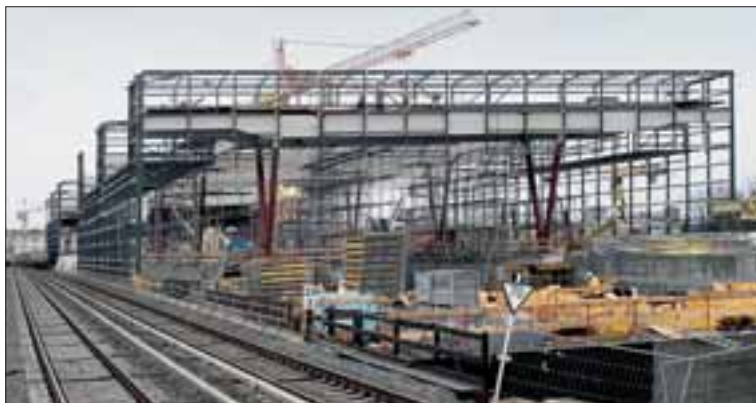
Die Ringbahnhalle Papestraße im Bau
