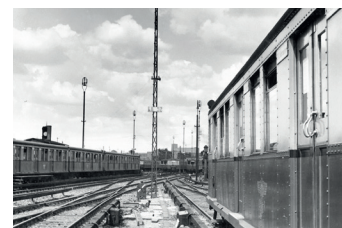
Güterbahnhof Charlottenburg Quelle: Historische Sammlung Deutsche Bahn
